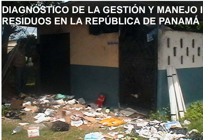
Foto N° 49. Depósito temporal no reglamentario en instalación del MINSA en Los Santos. (Año 2010).
