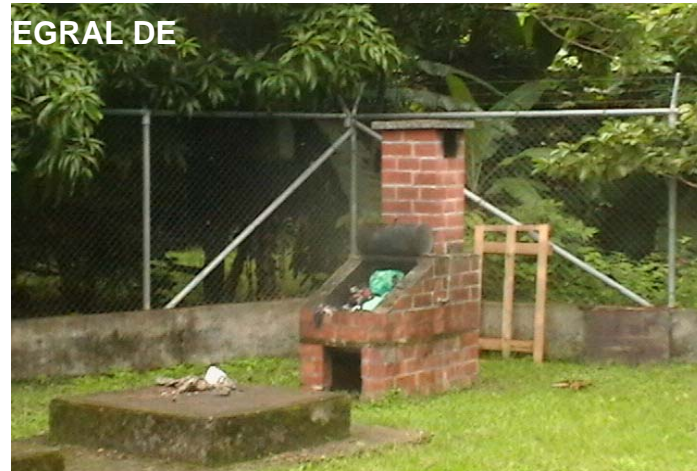
Foto N° 50. Incinerador rural en instalación de salud. (Año 2010).
